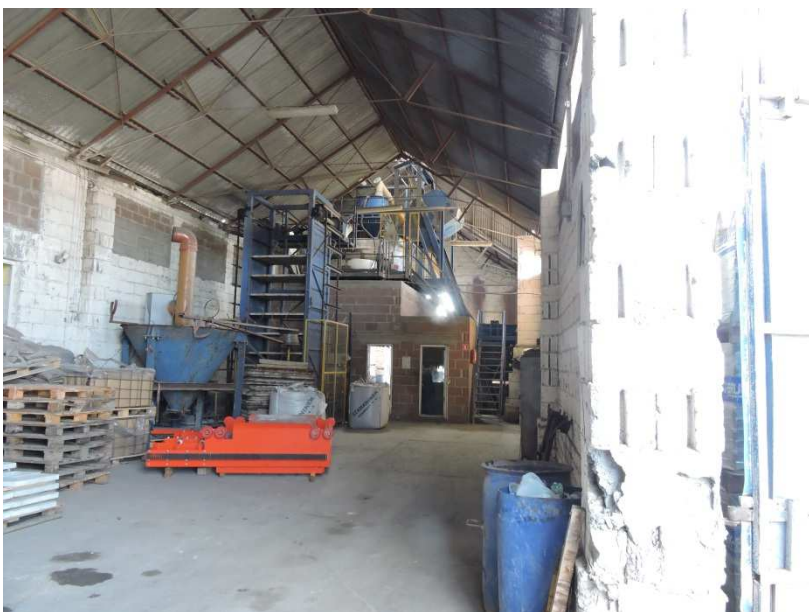
Zdj. 1 Istniejąca mieszarka nr 1 (wydajność 20 m 3 /h)
